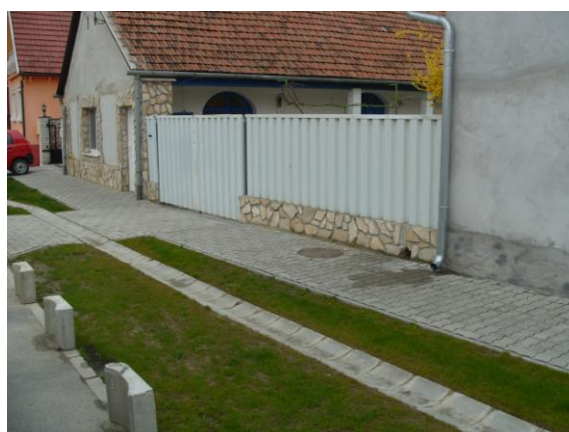
2007-ben megvalósított beruházás során az Arany J. utcában új út, járda, szennyvízcsatorna épült, a felszíni vízrendezés és a zöldterület rekonstrukció megtörtént.
