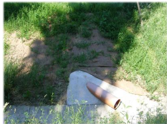
A tavaly megcsúszott löszpartban mélyelvezető csöveket helyeztek el.
