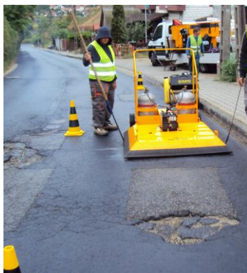
Az új melegítéses kátyúzási technológiával nem kell körbevágni a kátyút, így külön hulladék nem keletkezik.
