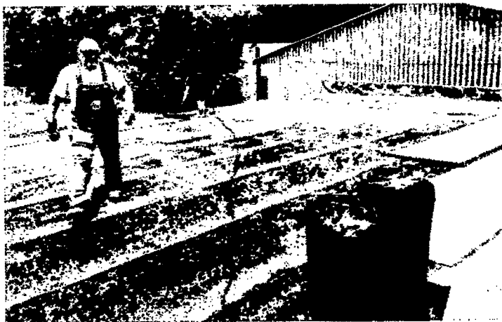
Lapostető javítása
