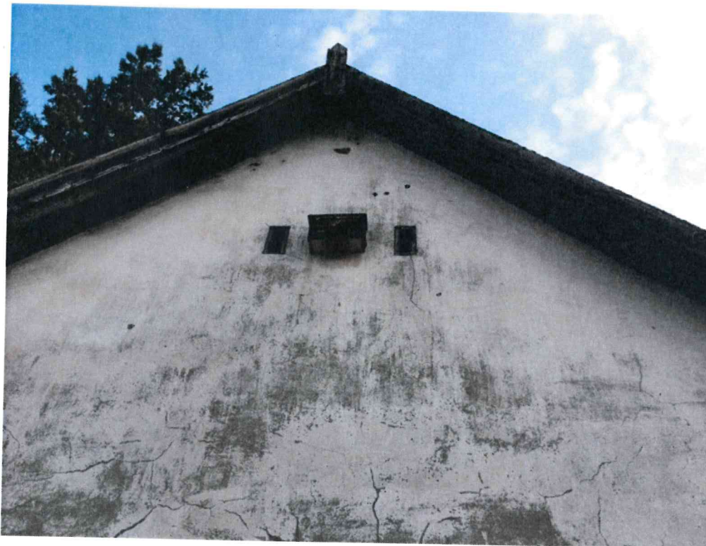
Padlásszellőzők az oromfalon
