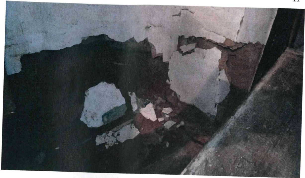
Részben megsemmisült vályogfal belül
