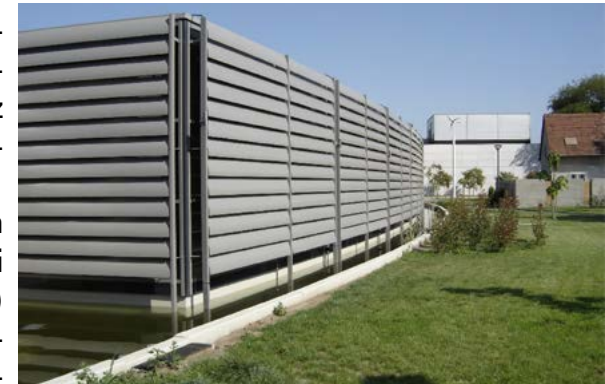
1. ábra A P épület árnyékoló zsaluzata és a szélerómű
