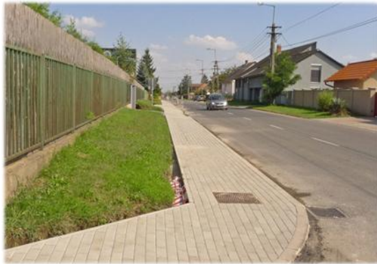
2014-ben járdafelújítás történt az Alkotás utcában, a Szabadság úton, a Venyimi úton és a Bartók Béla utcában. A járda felbontása után minden esetben térköves járdát alakítottunk ki a közlekedők számára.
