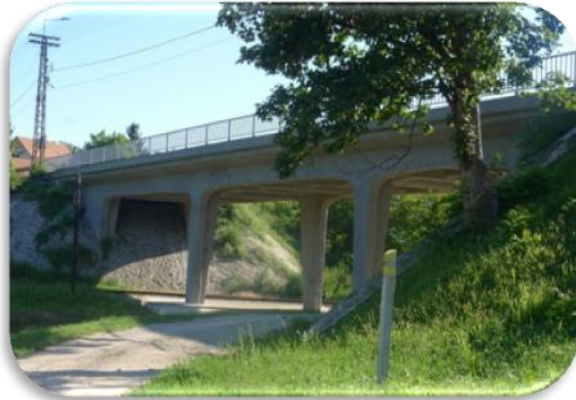
2016-ban megvalósult a veszélyes állapotba kerülő 100 lábú híd felújítása. Megtörtént a pályalemez felújítása, a vízvezetés megoldása, a burkolat cseréje és az új korlát kialakítása.
