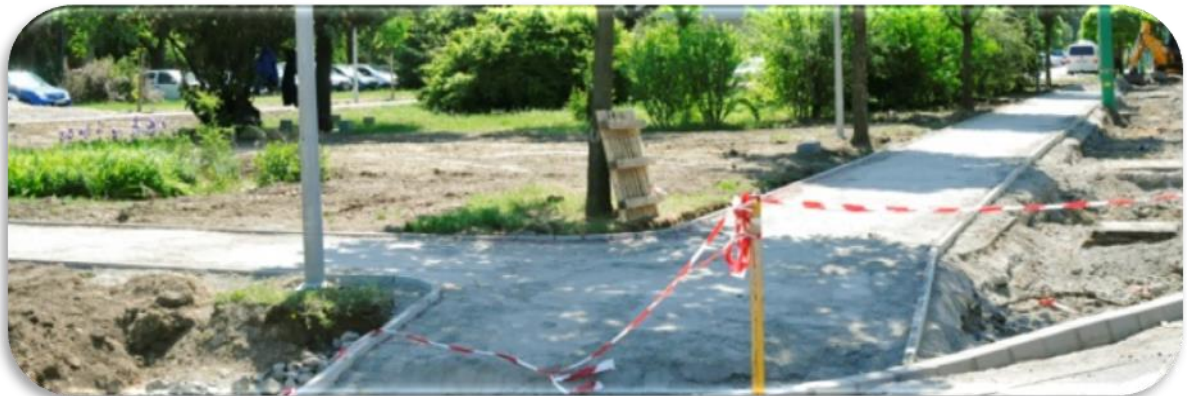
Megkezdődtek a Vasmű út parkjainak felújítási munkálatai
