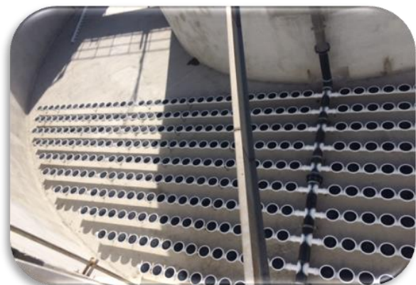
Lezárult a szennyvíztisztító telep felújításának II. üteme. A levegőztető medence építészeti felújítása során a fenék és oldalfalak vízzáró, korrózióálló réteget kaptak. A gépészeti felújítás során a mély-levegőztető rendszer kollektor vezetékek és membránfejek (1.314 db) cseréje, banánkeverők és tartószerkezetének cseréje, valamint a szondák cserje történt meg.
