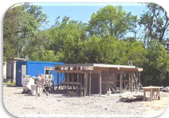
A csápos kút felszín feletti részének építése
