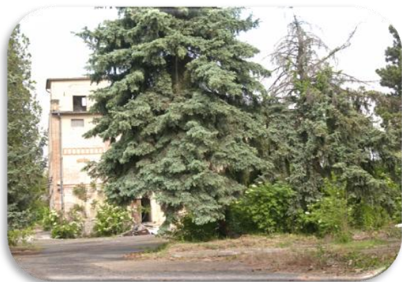
Megkezdődtek a Mondbach-kúria felújítási munkálatai
