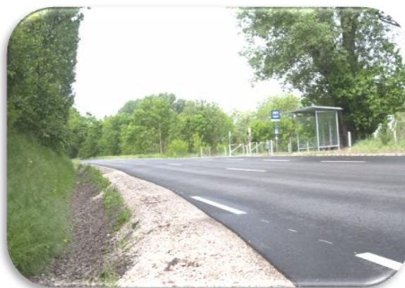
Megtörtént a Nagyvenyimre vezető út felújítása
