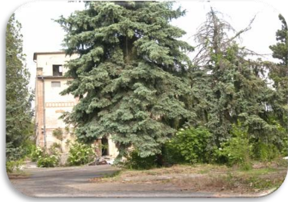
A Mondbach-kúria felújítási munkálatai jelenleg is zajlanak
