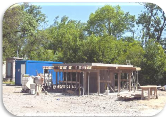
A csápos kút felszín feletti részének építése
