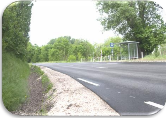
Megtörtént a Nagyvenyimre vezető út felújítása
